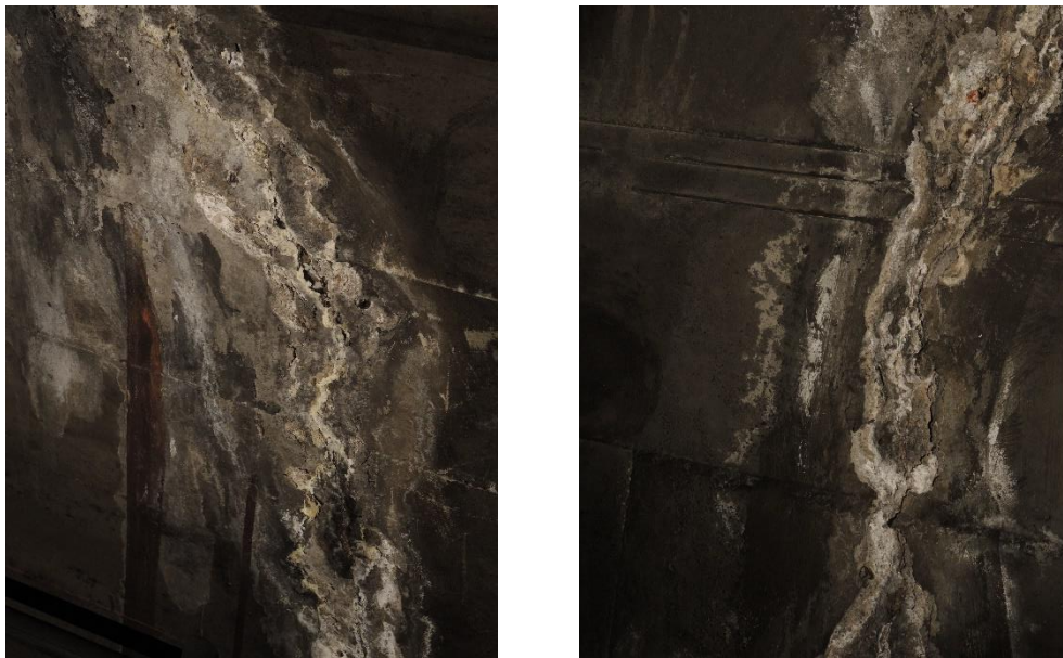
Abbildung 3: Unebenheiten an der Tunnelinnenschale aufgrund von Versinterungen an den Rissen oder durch Betoniergrate
