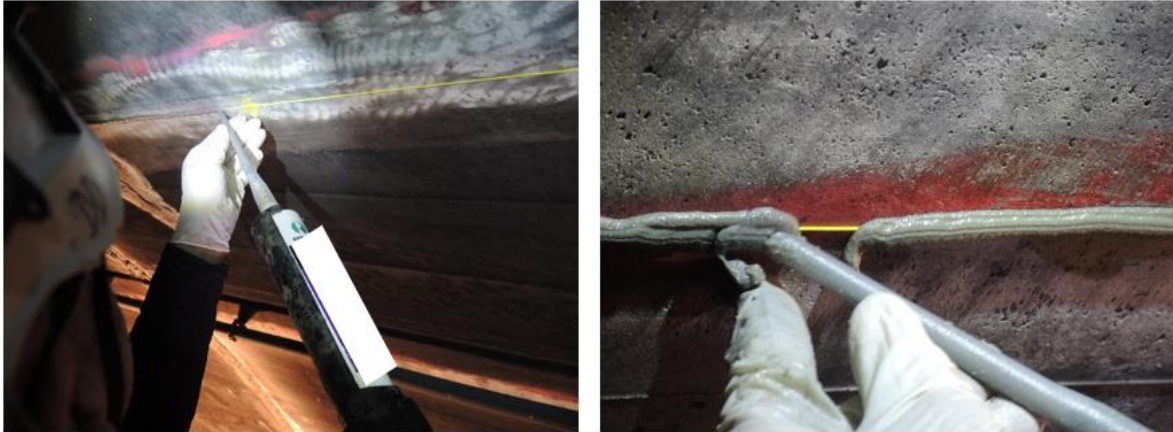
Abbildung 5: Aufkleben der faseroptischen Sensoren
