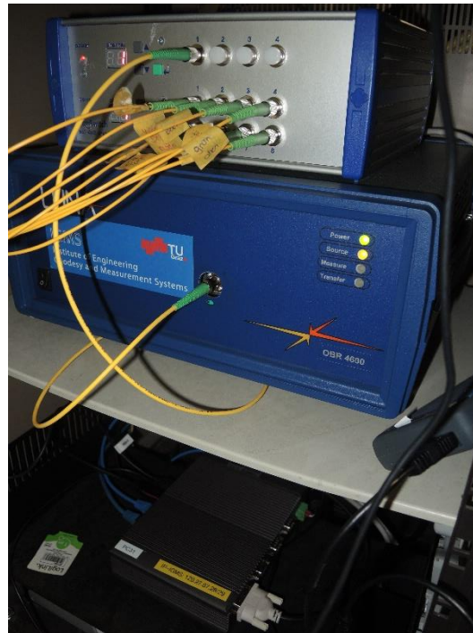
Abbildung 9: Platzierung des Messinstrumentes und des optischen Switches in einem gesicherten Messschrank
