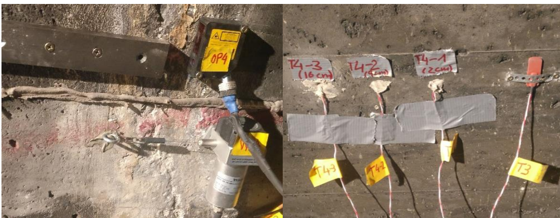
Abbildung 11: Beispiel der Montage der optoelektronischen Distanzsensoren und der Seilzugsensoren (links) und der Temperaturmessung (rechts). Bei der Temperaturmessung ist die Profilmessung wie auch eine Oberflächenmessung zu sehen.
