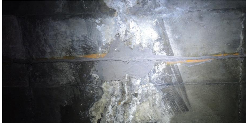
Abbildung 7: Verspachteln von groben Unebenheiten und anschließendes Verkleben der Faser
